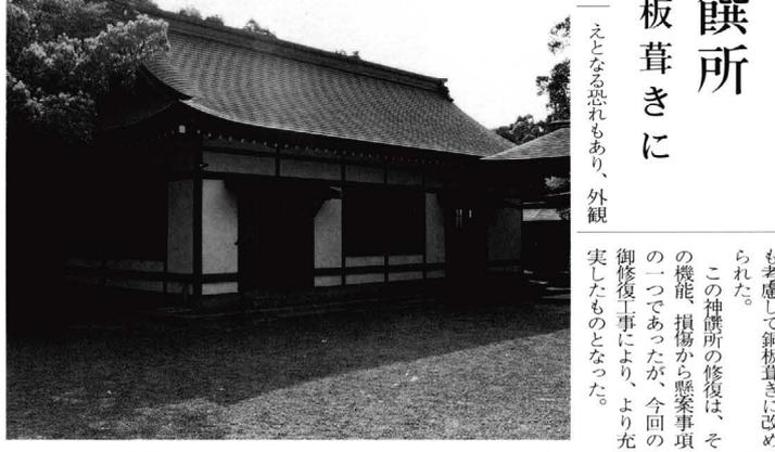
又、瓦葺きであった御屋根を銅板葺きとし、白壁の漆喰も塗り替えられ、装いも新たになった。この神饌所の修復は、その機能、損傷から懸念事項の一つであったが、今回の御修復工事により、より充実したものとなった。
